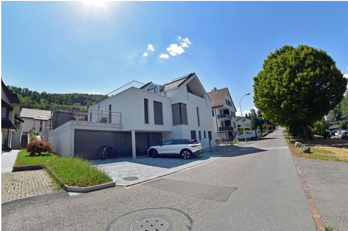
Liegenschaftszufahrt mit Garagen und Aussenparkplätzen
