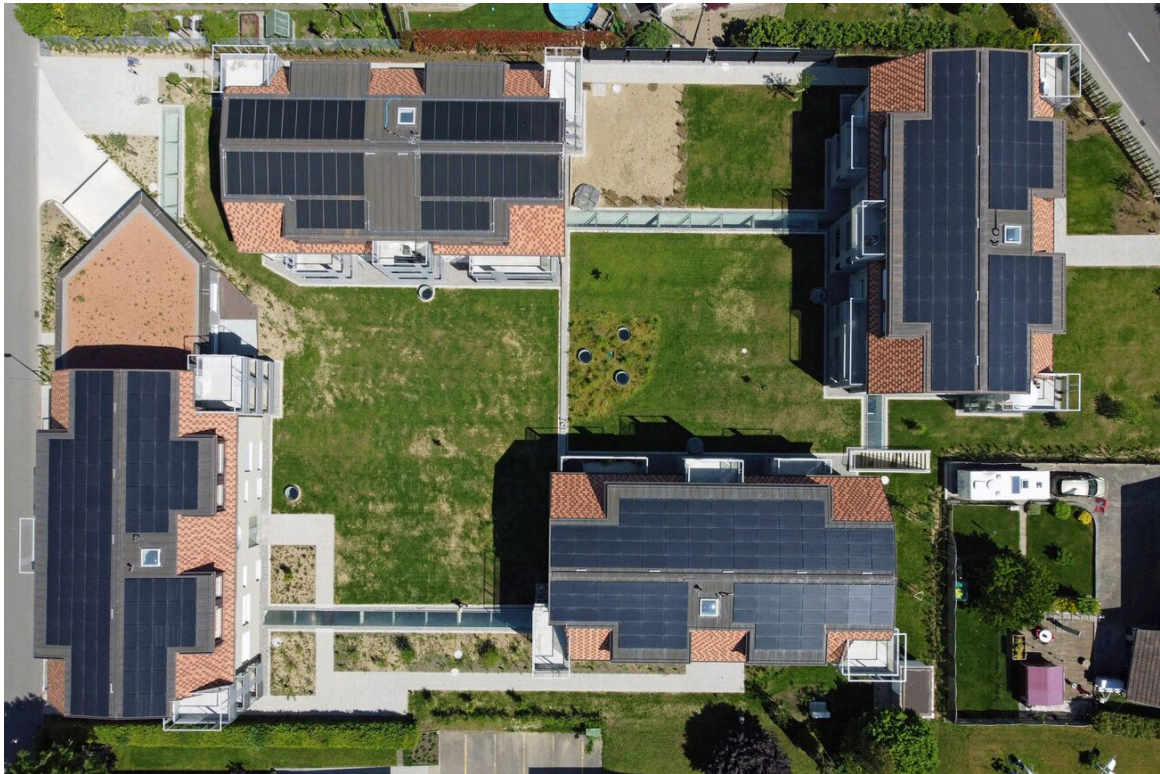
Nachhaltige Bauweise mit Solaranlage
