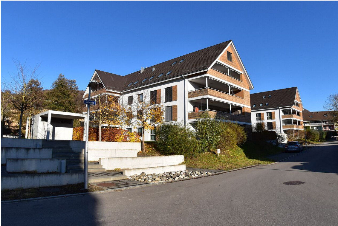
Die sonnenverwöhnte Süd-West Fassade
