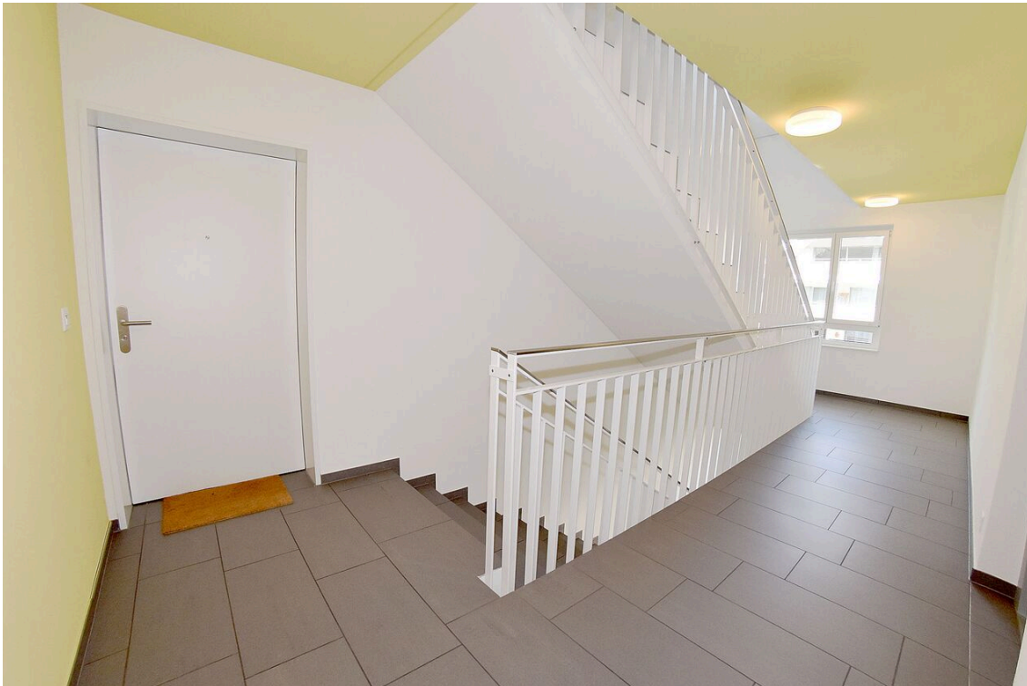
Treppenhaus mit Lift
