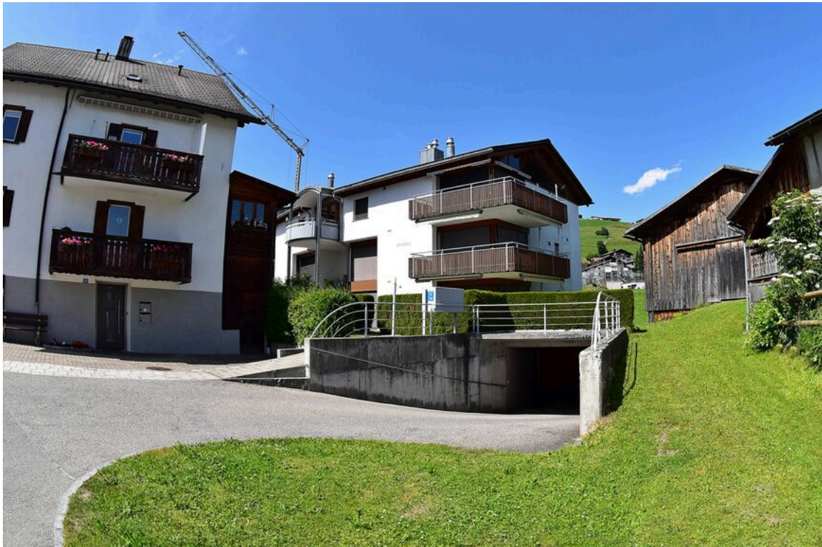
Einfahrt zur Tiefgarage
