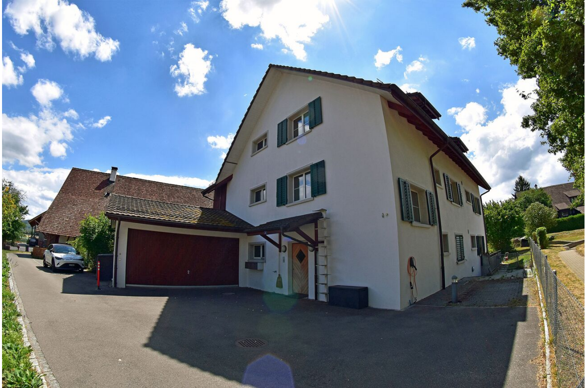
Hauszugang auf der Nordseite
