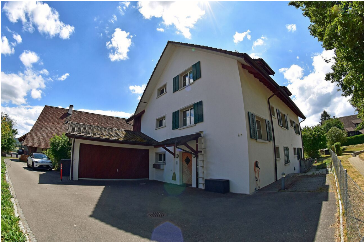
Hauszugang auf der Nordseite
